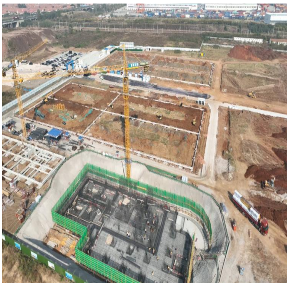
山东高速上合经贸产业园项目建设
