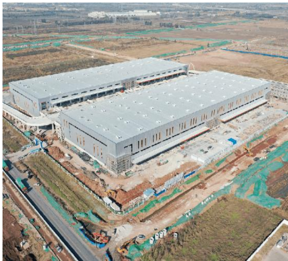
胶东机场货运区物流仓储项目建设
